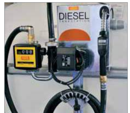
pomp-console met 230V pomp 70l/min, teller K33, tankpistoolhouder, slanghouder en aftankslang 4m
