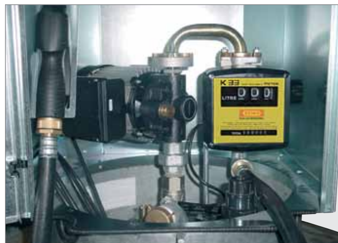
Viscomat 90 kpl. met teller K33, voor smeeroilie en plantaardige olie
