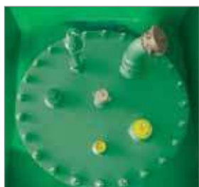
mangatdeksel met aansluitingen
