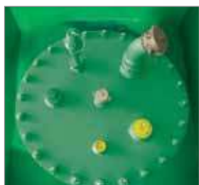
mangatdeksel met aansluitingen
