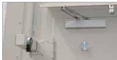
registripen boven de deur (basisuivoering), deurvastzetting en bovendeursluiser met sluitvolgeregeling bij 2-vleugelige deur (toeboren)
