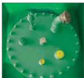
mangatdeksel met aansluitingen
