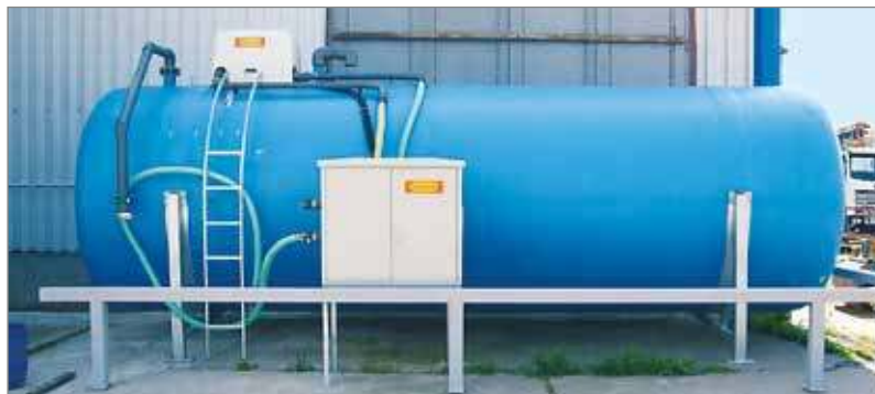
Compleet geïnstalleerde natzoutinstallatie incl. pompeenheid
