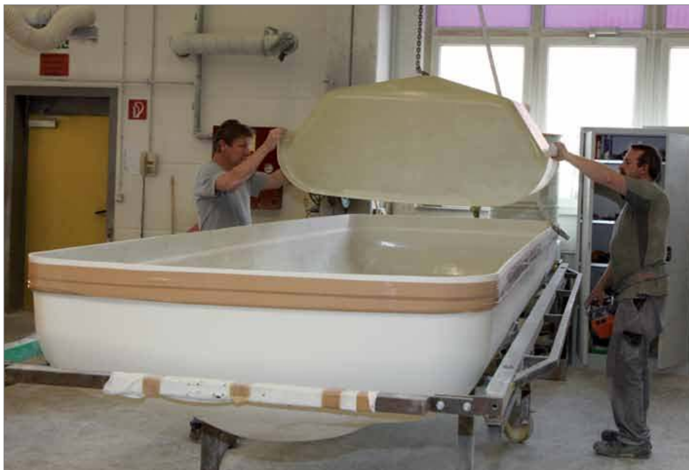
monteren van klotswanden in GVK -vat
